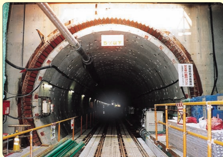
工事中の雨水幹線
