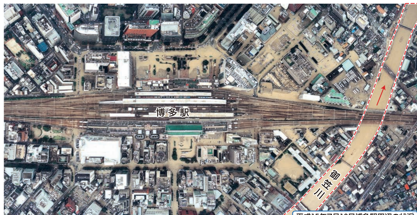
平成15年7月19日博多駅周辺の状況
